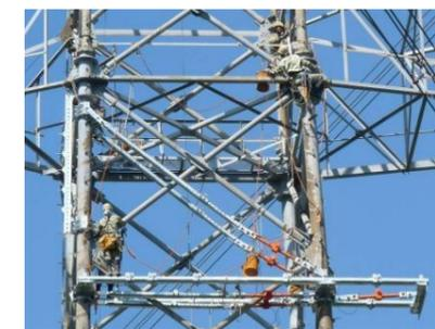
部材取替補強治具取付
