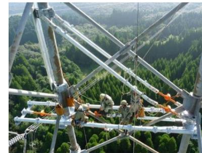
部材取替補強治具取付
