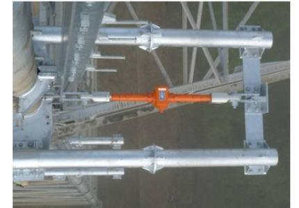
部材取替補強治具取付
