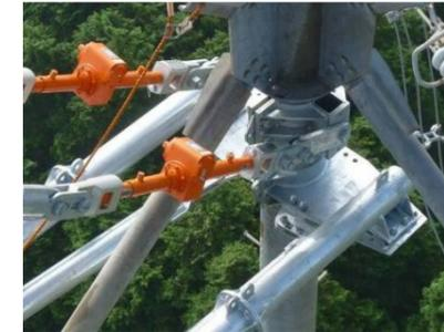
水平補強治具(塔外側)
