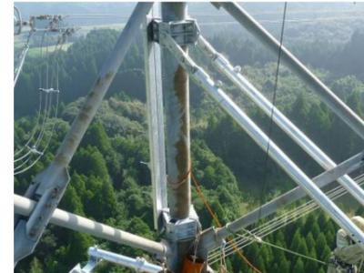
斜引き緊張装置固定用支柱材バンド
