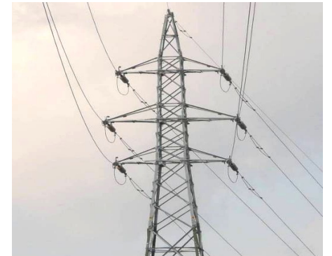
Step⑨ 仮設鉄塔解体撤去並びに 接続部取外し完了
