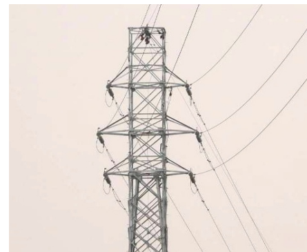
Step⑤ 反対側回線電線移線, 既設腕金解体撤去, 既設鉄塔解体
