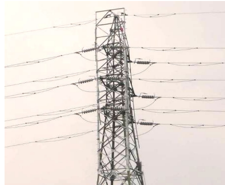
Step② 仮設鉄塔組立(1面)
