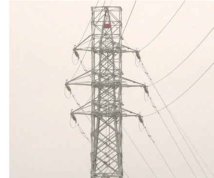
Step⑦ 新設鉄塔片側回線腕金 組立並びに電線地線移線, 仮設鉄塔腕金解体撤去
