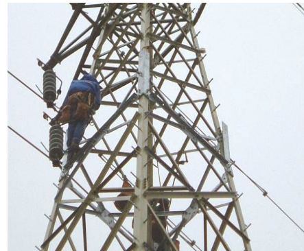
Step① 仮設鉄塔接続部取付
