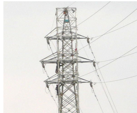
Step③ 仮設鉄塔組立終了, 仮設腕金取付
