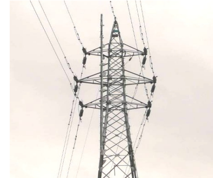
Step⑧ 新設鉄塔反対側回線腕金 組立並びに電線移線, 仮設鉄塔並びに腕金解体 撤去
