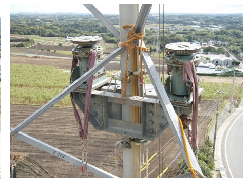
Step③ 油圧ジャッキ取付
