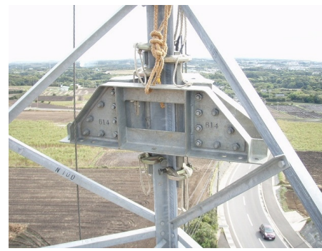
Step① 上部金具取付
