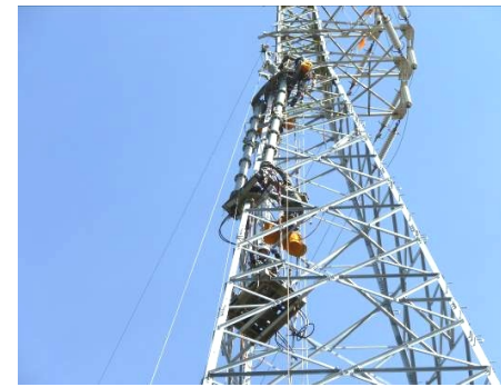
Step④ サポートパイプ取付
