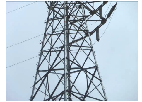
Step⑥ 主柱材取替え完了
