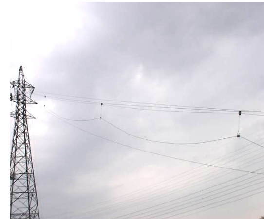
鳥栖久留米線No.3~No.5電線撤去状況
