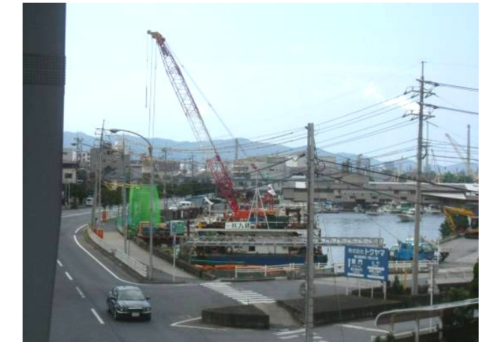
杭打作業状況 全景
