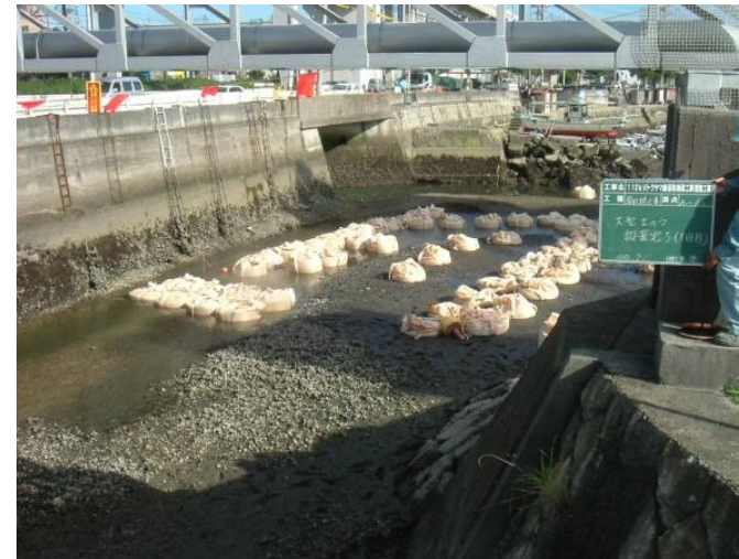
大型土嚢設置状況
