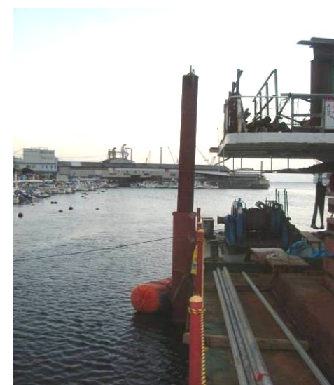
スライドスパッツ設置状況
