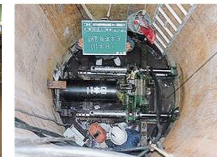
小口径推進工事(マシン外径φ200mm)
