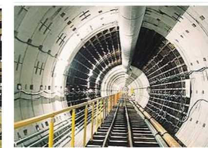
シールド工事(一次覆工φ3,500mm)
