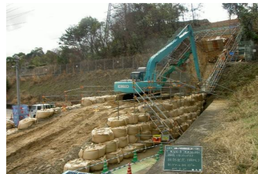
管路埋設状況(防護コンクリート胴締め方式)
