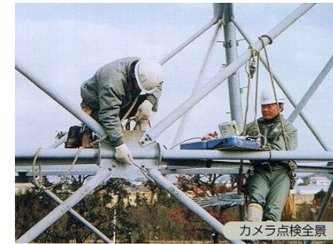
カメラ点検全景
