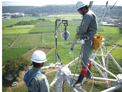
点検装置の設置
