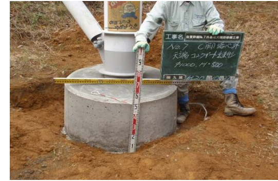
step⑥ 基礎コンクリート打設
