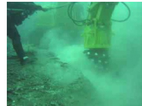
岩盤層削岩作業状況
