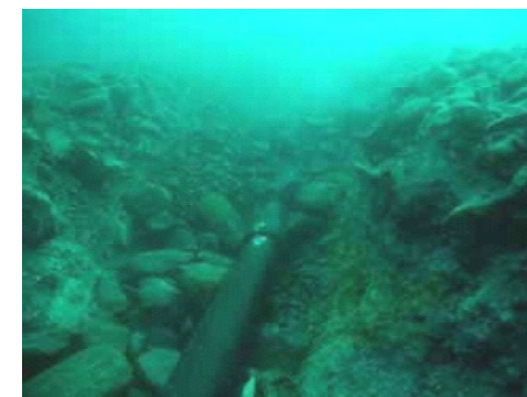
ケーブル防護管設置状況
