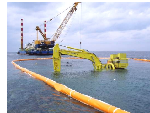
作業状況(写真奥は支援船)
