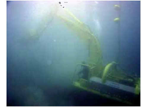
掘削作業状況
