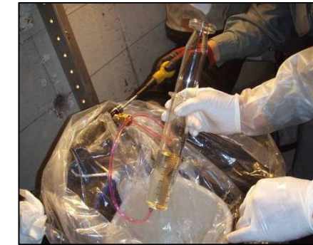
ジョイントボックスからの採油状況
