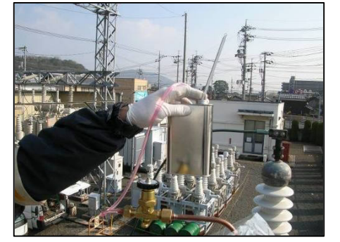
終端箱からの採油状況
